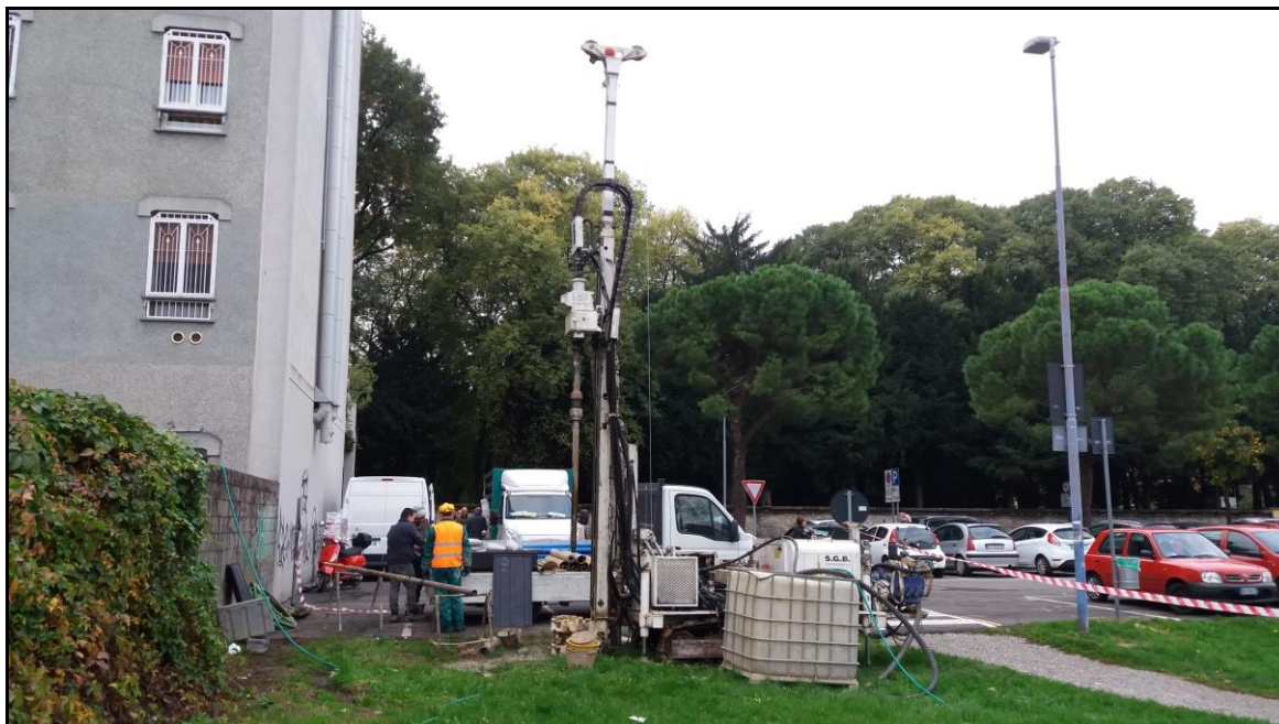
Fig. 13: perforazione a carotaggio continuo del sondaggio S1 eseguito in data 28 ottobre 2016
