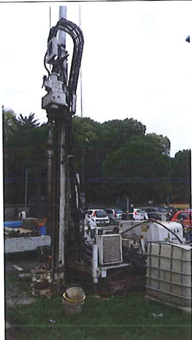
Foto 7: esecuzione sondaggio S1 di profondità 15 m da p.c., realizzato con il metodo di perforazione a carotaggio continuo; in tal modo è risultato possibile osservare direttamente e descrivere la tipologia di sedimenti incontrati lungo la verticale di scavo (vedi fig. 8, 9 e 10)
