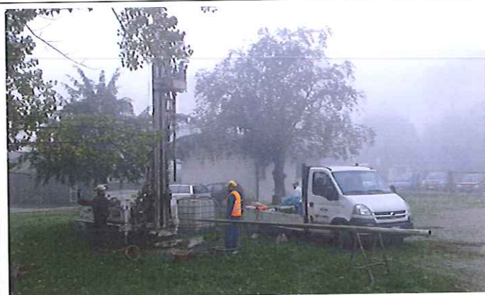
Foto 5: esecuzione sondaggio S3 di profondità 12 m da p.c., realizzato con il metodo di perforazione a carotaggio continuo; in tal modo è risultato possibile osservare direttamente e descrivere la tipologia di sedimenti incontrati lungo la verticale di scavo (vedi fig. 6, 7 e 8)
