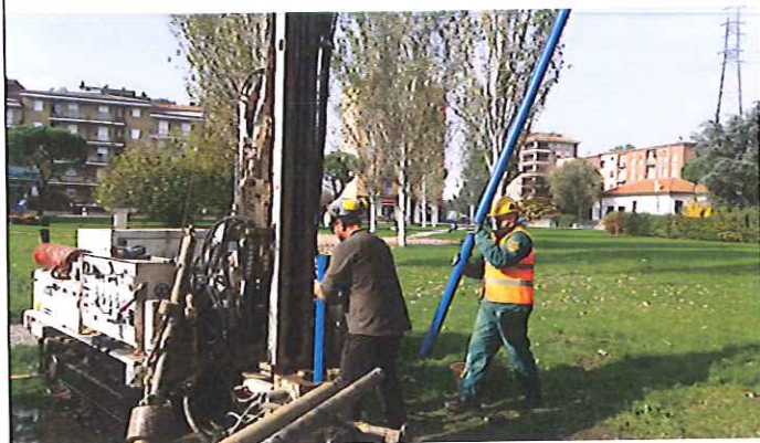
Foto 13: inserimento nel foro di sondaggio di tubi in PVC azzurri per la realizzazione del piezometro
